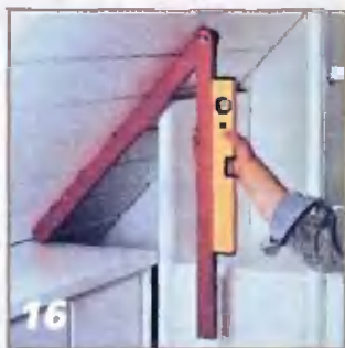
16 Угол между наклонной стеной и вертикалью определяют с помощью малки и уровня.
