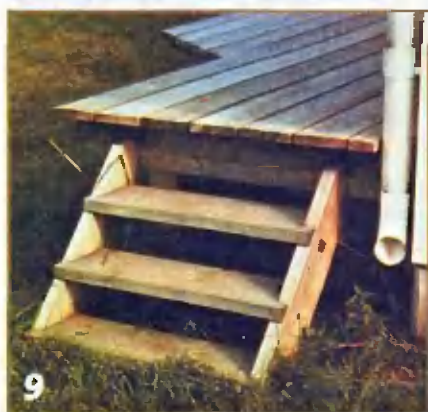
Размеры досок для ступеней — 45x220, для тетивы — 45x170 мм. Торцы досок обрабатывают защитным масляным средством по дереву. Особое внимание уделяют местам, контактирующим с землей.
