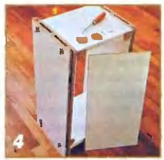
Заднюю стенку крепят после сборки основных деталей корпуса.
